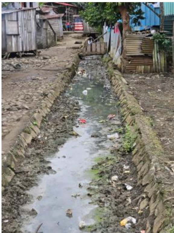
Figura 2-2 : Exemplo de esgoto entupido na Ribeira Afonso
